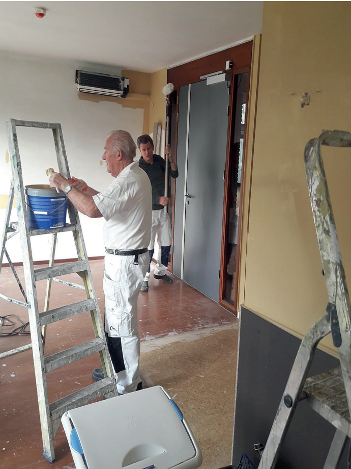
De klusploeg is begonnen met de ombouw van de eerste van de acht gastenkamers
